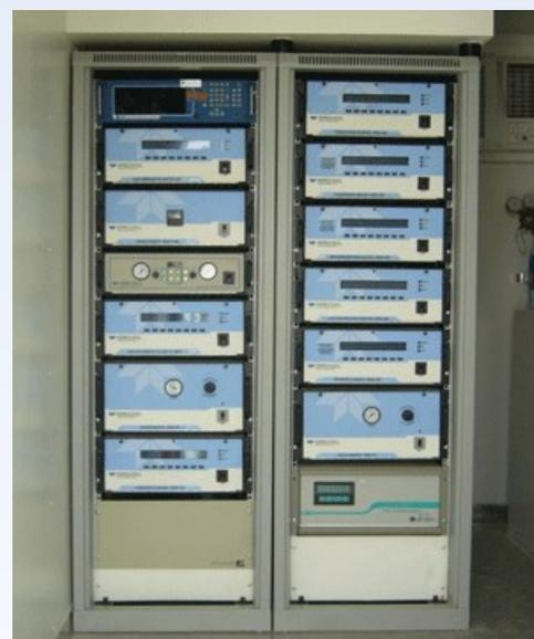
Рис. 3– Наглядный пример анализаторной системы мониторинга выбросов.
