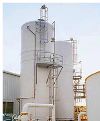
Если при наполнении цистерны или резервуара уровень жидкости повышается, газообразная фаза уменьшается в объеме, и для удаления кислорода из системы требуется меньше азота, что позволяет снизить расход подаваемого азота.
